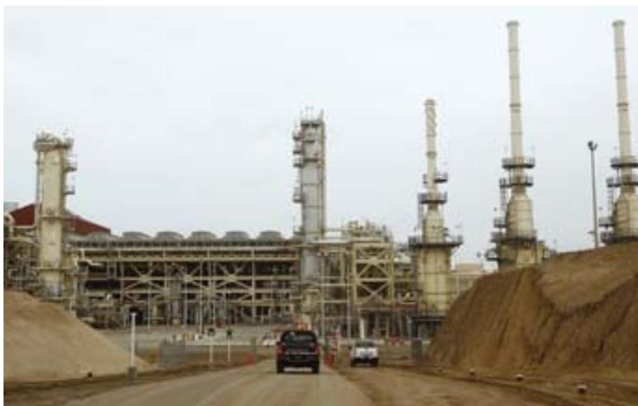
> La moderna planta de licuefacción de Melchorita en la costa de Perú. La instalación industrial licúa el gas natural llegado desde los yacimientos de Camisea, situados a 400 kilómetros de distancia en el interior del país. Stream opera la flota de gaseros que exporta el gas licuado en la planta.
