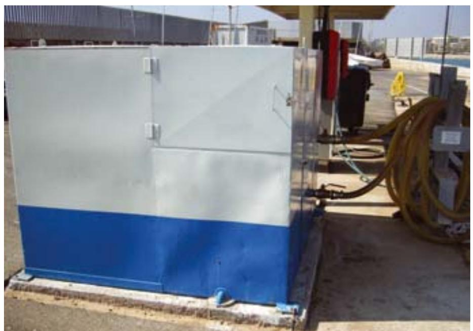
➤ Imagen exterior del módulo controlado de recepción de aguas sucias y de sentinas. Por la válvula superior acceden las aguas de sentinas, por la inferior las aguas sucias.
