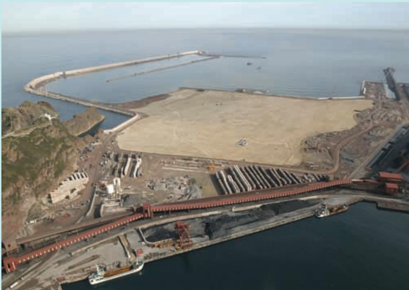
▲ Trabajos de relleno en la Mota. Al norte de la cinta transportadora que enlaza con la explanada de Aboño se alinean bloques antes de su instalación. En último término, el dique de Abrigo aparece concluido y se perfila el muelle Norte.
