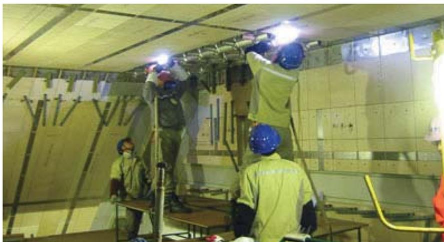
▲ Montaje de una de las membranas en el interior de un tanque GTT.
