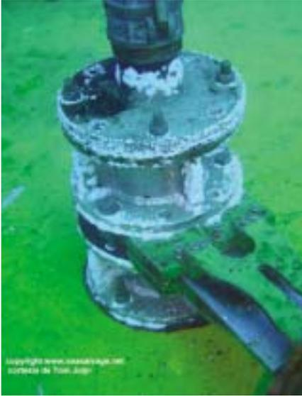
▲ Válvula de “hot-tap”. Estas válvulas se instalan durante la realización del taladro. La válvula intermedia permite retirar el equipo sin que se produzcan fugas de combustible.
