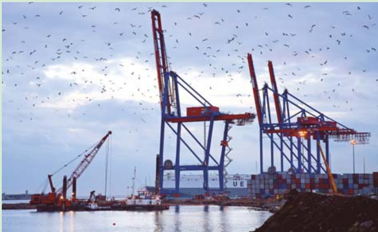
La terminal de contenedores en el nuevo Muelle 9, en pleno proceso de ampliación.
