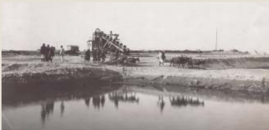
Poco antes de abrirse el canal de la Bocana, aquí se puede ver el último muro y la diferencia de nivel entre el Mediterráneo y la Mar Chica. Al fondo, la draga terrestre utilizada en la apertura. (Foto: archivo de los autores.)
