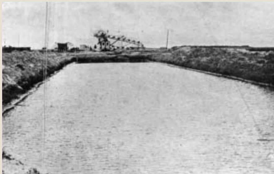
La draga terrestre trabajando en la apertura del canal de la Bocana. (Foto: archivo de los autores.)
