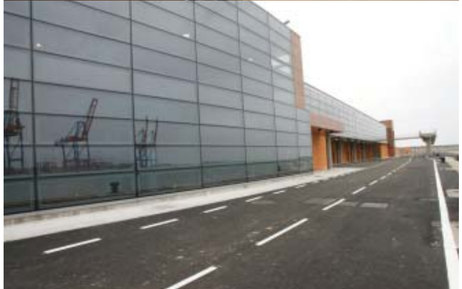
▲ Interior y exterior de la Estación Marítima.
