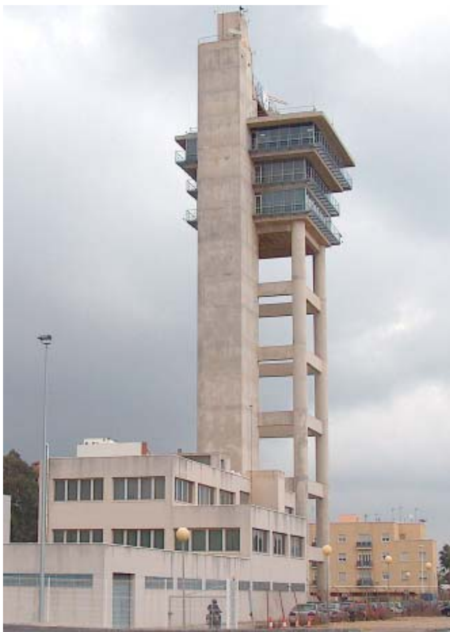
▲ El capitán marítimo podrá organizar su equipo asesor con personal técnico de la Capitanía Marítima y de Salvamento Marítimo. En la fotografía, Capitanía Marítima y Centro de Coordinación de Salvamento Marítimo de Algeciras.
