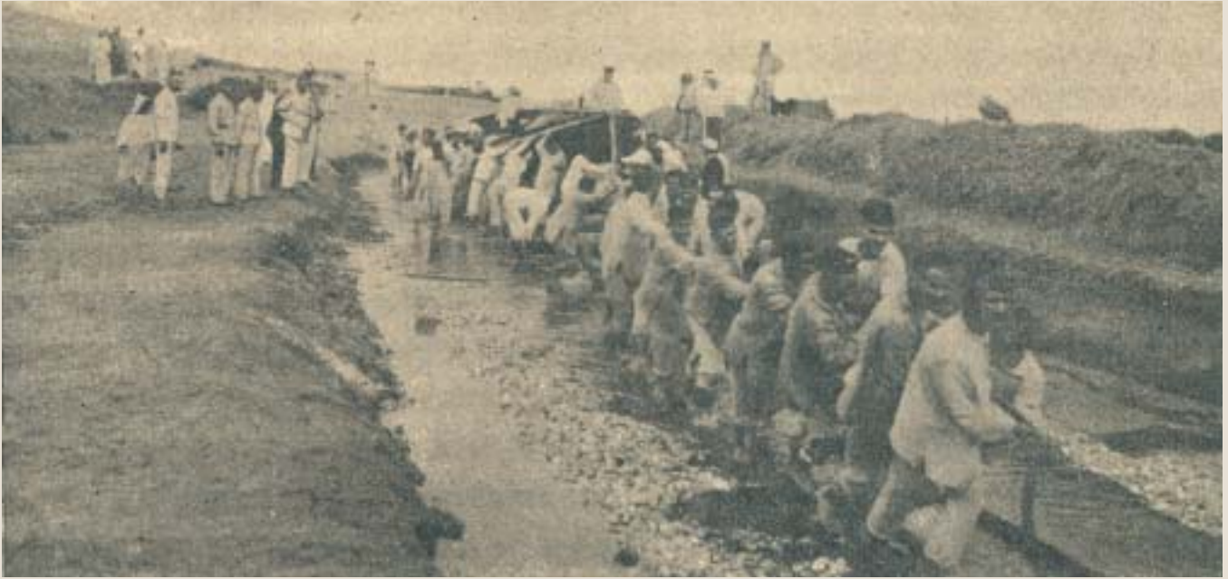
Otra vista de los grandes esfuerzos que hubo que realizar para pasar las embarcaciones a la Mar Chica. El canal por el que se desliza la lancha fue excavado a mano por fuerzas de ingenieros. (Foto: archivo de los autores.)
