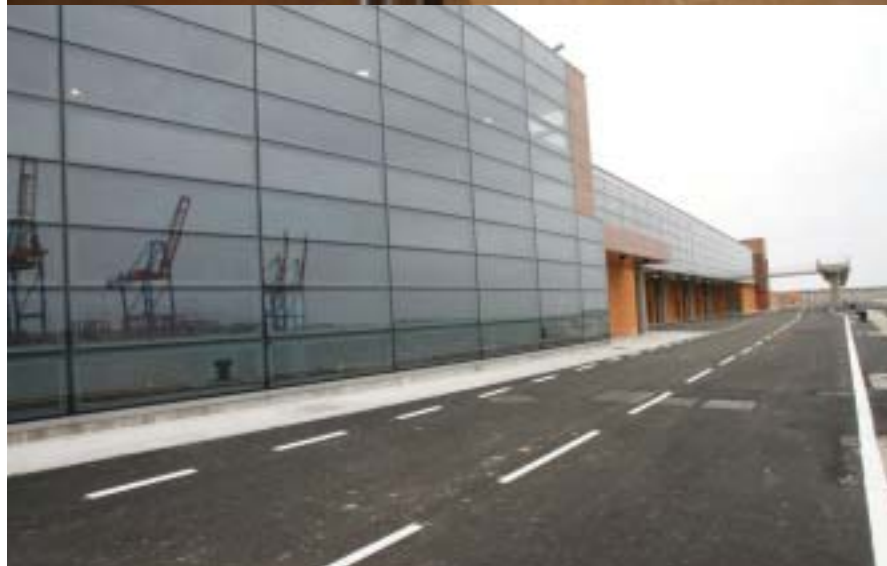
▲ Interior y exterior de la Estación Marítima.
