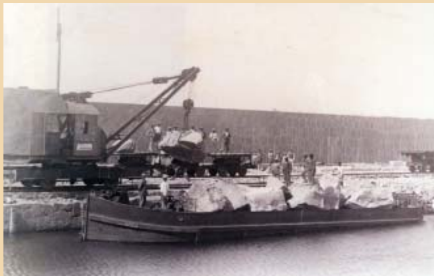
Una de las gabarras que se utilizaron para transportar los materiales que conformaron la escollera. (Foto: archivo de los autores).
