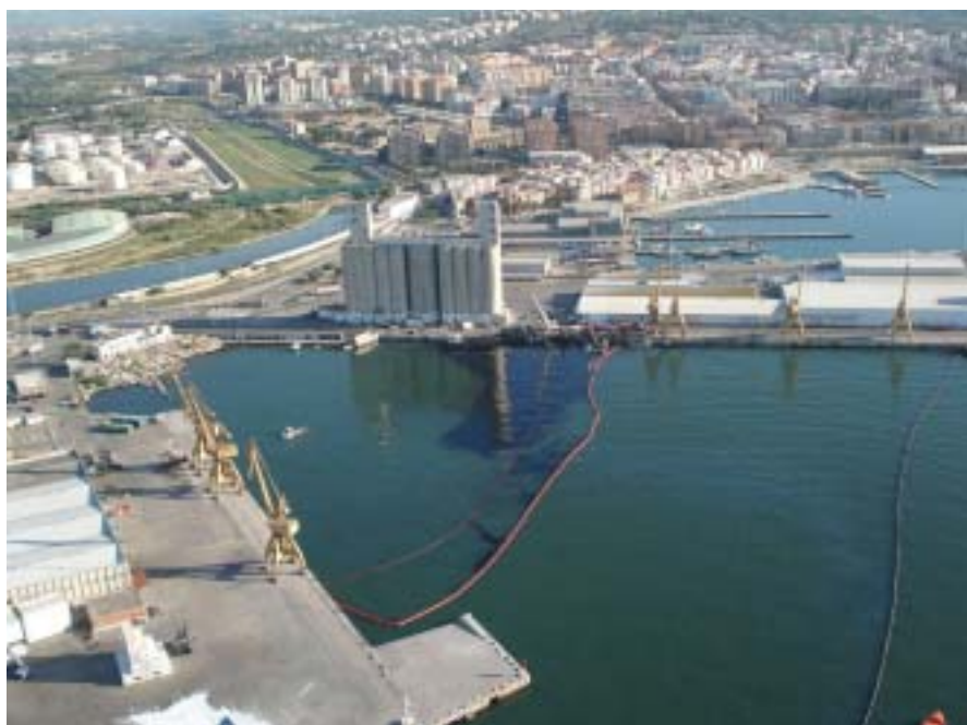
▲ Pérdida contenida en la primera batería de barreras en la dársena del muelle de Reus.
