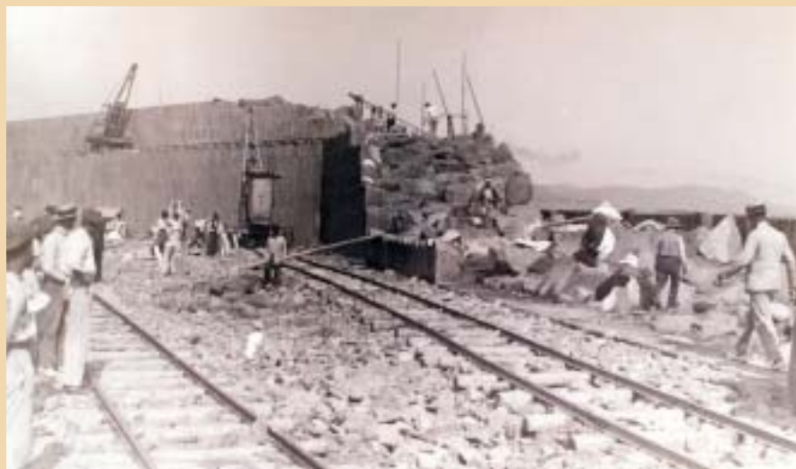
Rotura en el malecón del puerto de Melilla producida por un temporal. Estas situaciones se projiuieron hasta que se reforzaron convenientemente. (Foto: archivo de los autores).
