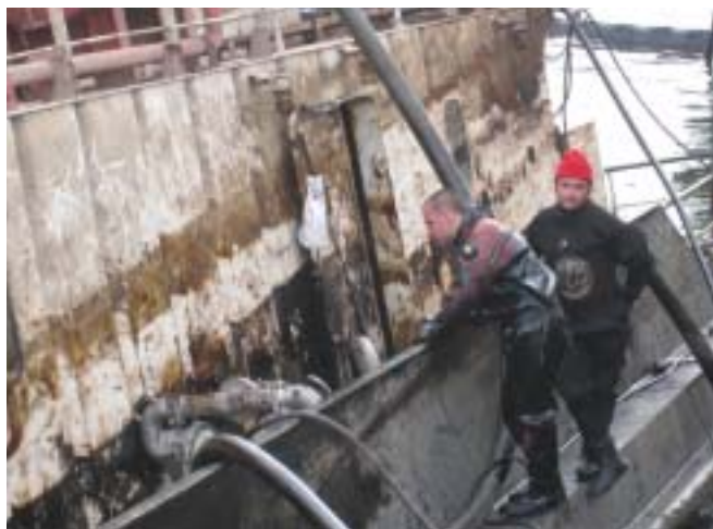
▲ Gabarra ya a flote con los buzos de INSTALSUB.
