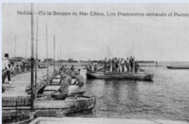
Vista del puente de pontones sobre el canal de la Bocana. Fue instalado en 1921 por fuerzas del Cuerpo de Ingenieros.
