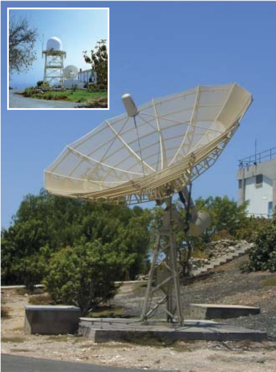
▲ Antenas del LEOLUT y GEOLUT de la Estación Espacial de Maspalomas.
