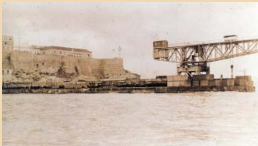
Construcción del puerto de Melilla. La grúa "Titán", en el extremo del muelle, estaba dedicada a mover los bloques de hormigón. (Foto. archivo de los autores).
