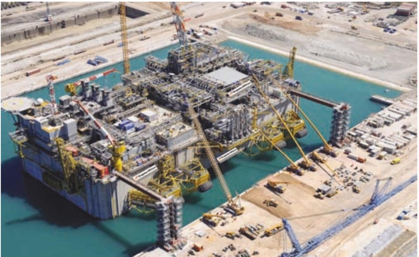
▲ Foto aérea de la Terminal en su última fase de construcción. Se pueden observar sobre la base de hormigón los módulos para la descarga, almacenamiento, regasificación y lanzamiento del gas fabricados e instalados por DRAGADOS OFFSHORE.
